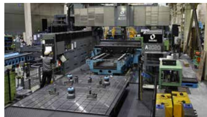
工場内の大型仕上げ機「A2020」と横形MC大型ベッド。
